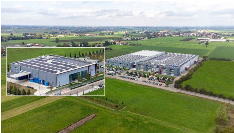
Esterno Innovation Center e ampliamento stabilimento produttivo Walvoil a Caviago, Reggio Emilia
