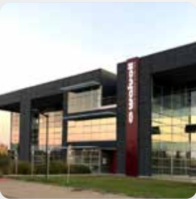
Galtech Site Cavriago (RE) • Italy
