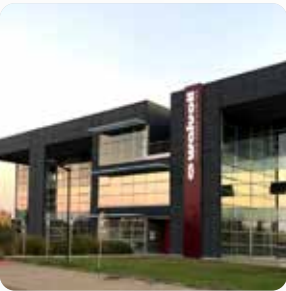
Galtech Site Cavriago (RE) • Italy
